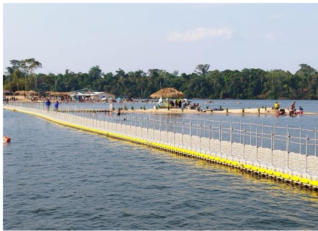
Passarela Flutuante – Paranaita
