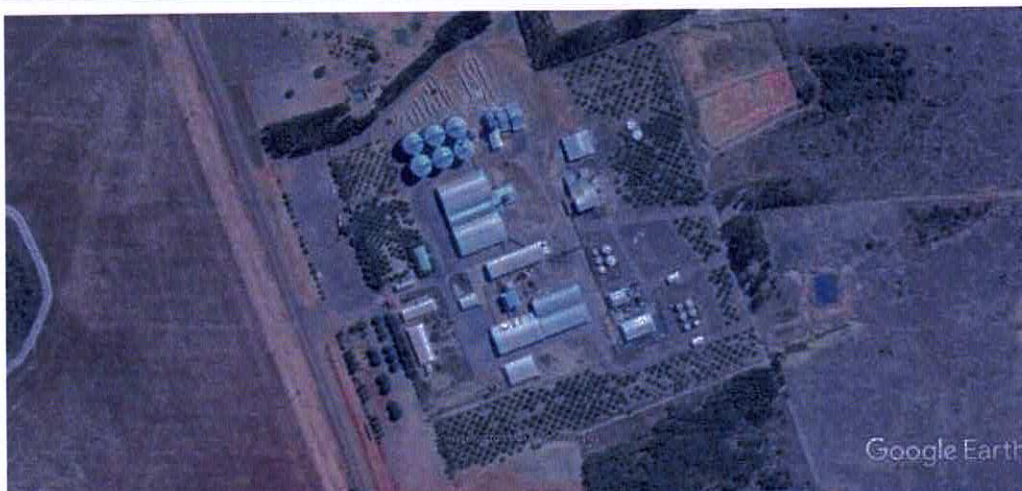
Figura 14 – Indústria de óleos vegetais 7SETE AGROINDUSTRIAL instalada na cidade de Porto Alegre do Norte
